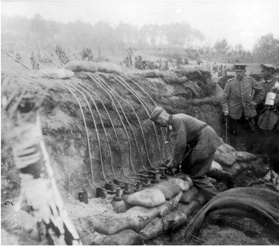
Fig. 1. Predisposizione delle bombole di cloro all'interno di una trincea tedesca. Le bombole venivano interrate in controscarpa e coperte con sacchetti di terra; un tubo di rame le connetteva al parapetto.
